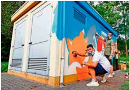
Die beiden Sprayer aus Suhl – MRN.Uno und Dekor (von links) – haben in den vergangenen zwei Tagen das Trafohäuschen an der Schönauer Straße, Ecke Obermühle, verschönert.
